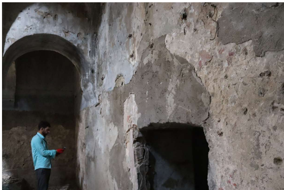
İkinci zalın divarlarının vəziyyəti
