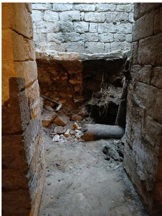
Dama çıxış pilləkəninin yerinə doldurulmuş qalıqların təmizlənməsi
