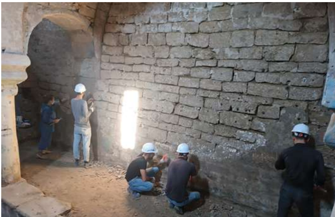
Birinci zalda sementli suvaqların təmizlənməsi
