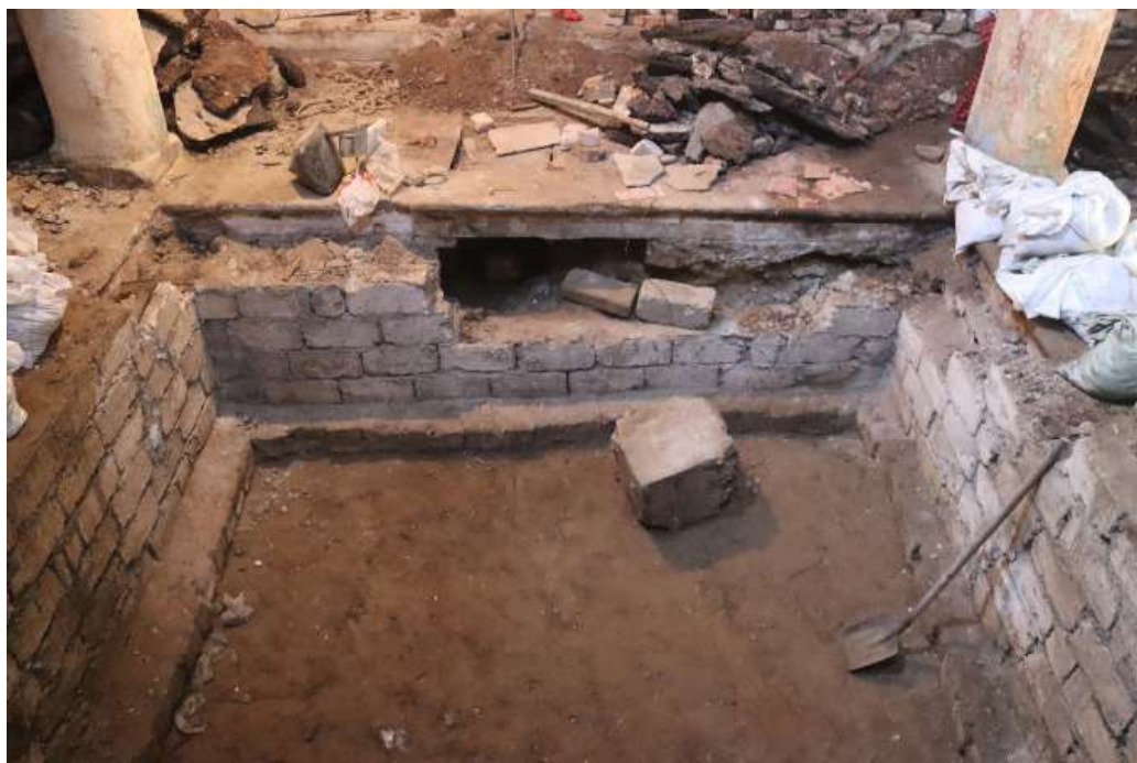
İkinci zalda istilik sistemi kanallarının aşkar olunması
