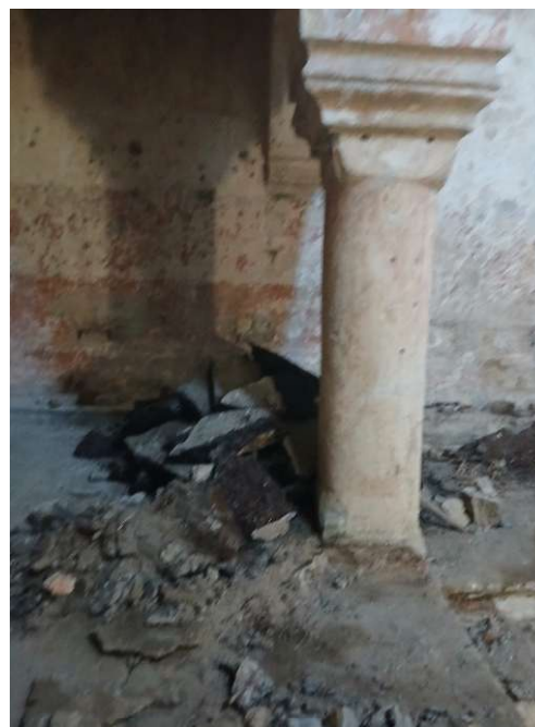
İkinci zalda asfalt təbəqələrin təmizlənməsi
