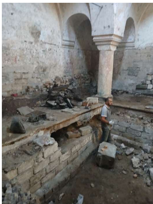
İkinci zalda asfalt təbəqələrin təmizlənməsi
